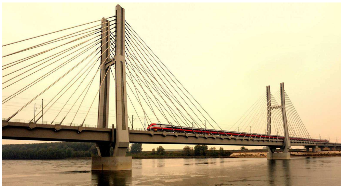
Obr. 3 Unikátní konstrukce 400 m dlouhého visutého mostu s mostovkou z předpjatého betonu překračující řeku Pád na VRT Milano – Bologna (IT)
