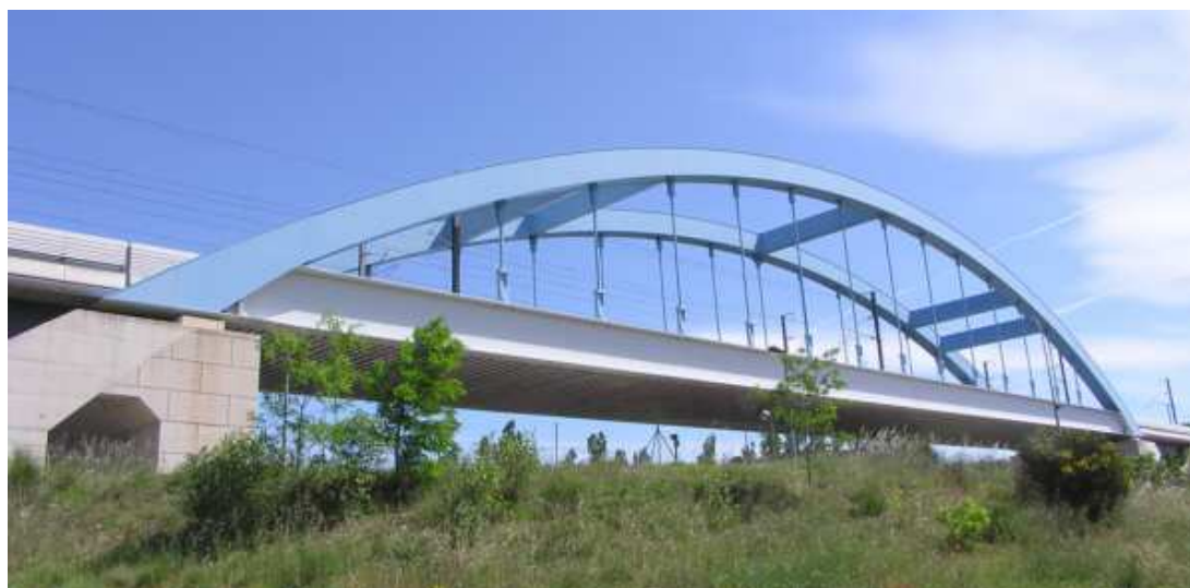
Obr. 9 Most na VRT přes dálnici A7 u Bonpas (FR) – Langerův trám (rozpětí 124 m)
