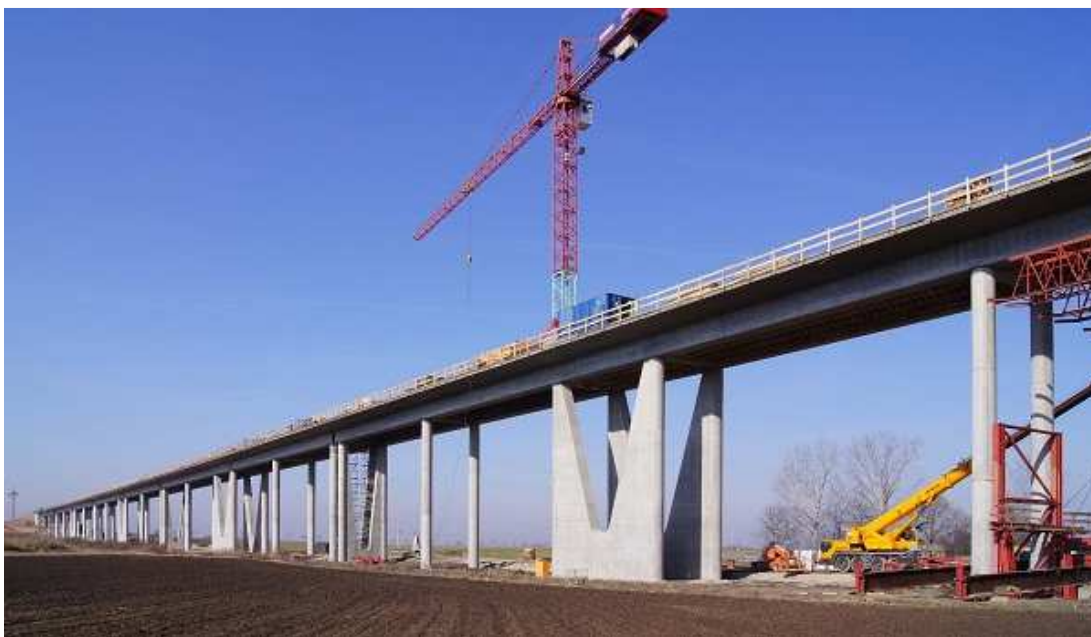
Obr. 24 Brzdné pilíře na estakádě Gänsebachthalbrücke (DE)
