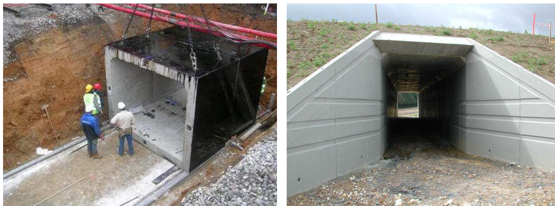
Obr. 21a,b Příklad přesýpaného betonového rámového propustku z prefabrikátů postaveného na VRT ve /FR/
