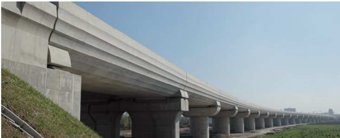
Obr. 14 Železniční estakáda s mostovkou průřezu Omega - „Modena Viaduct“ na VRT Milan-Bologna (IT)
