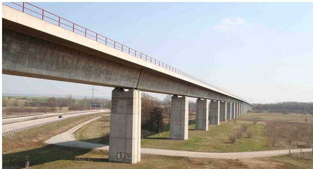
Obr. 18 Soustava prostých komorových předpjatých nosníků – Geraltalbrücke (DE)
